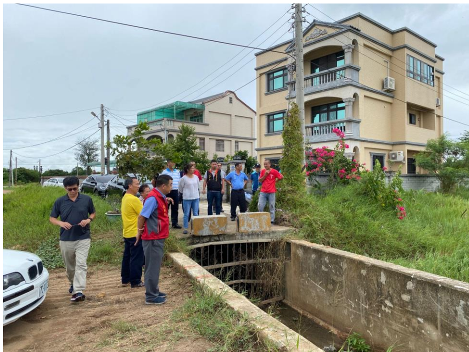
視察西浦頭大排水溝加蓋以利通行
