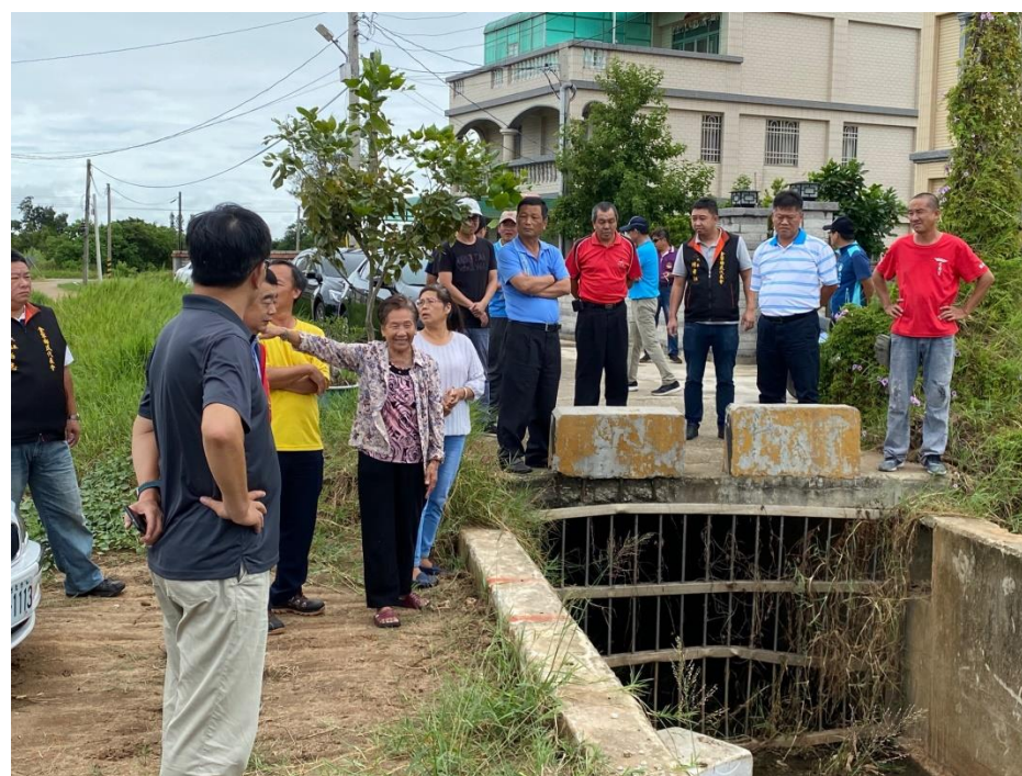
視察西浦頭大排水溝加蓋以利通行
