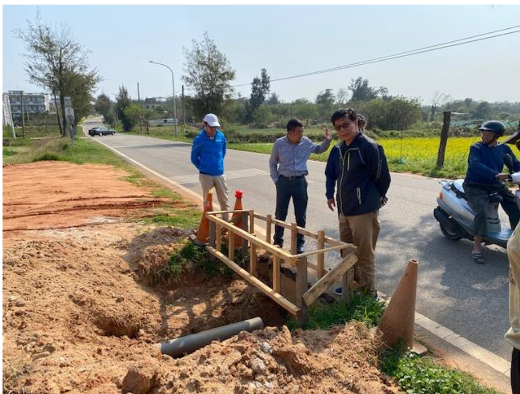
考察西浦頭李光前將軍廟前路旁深坑及新建屋排水
