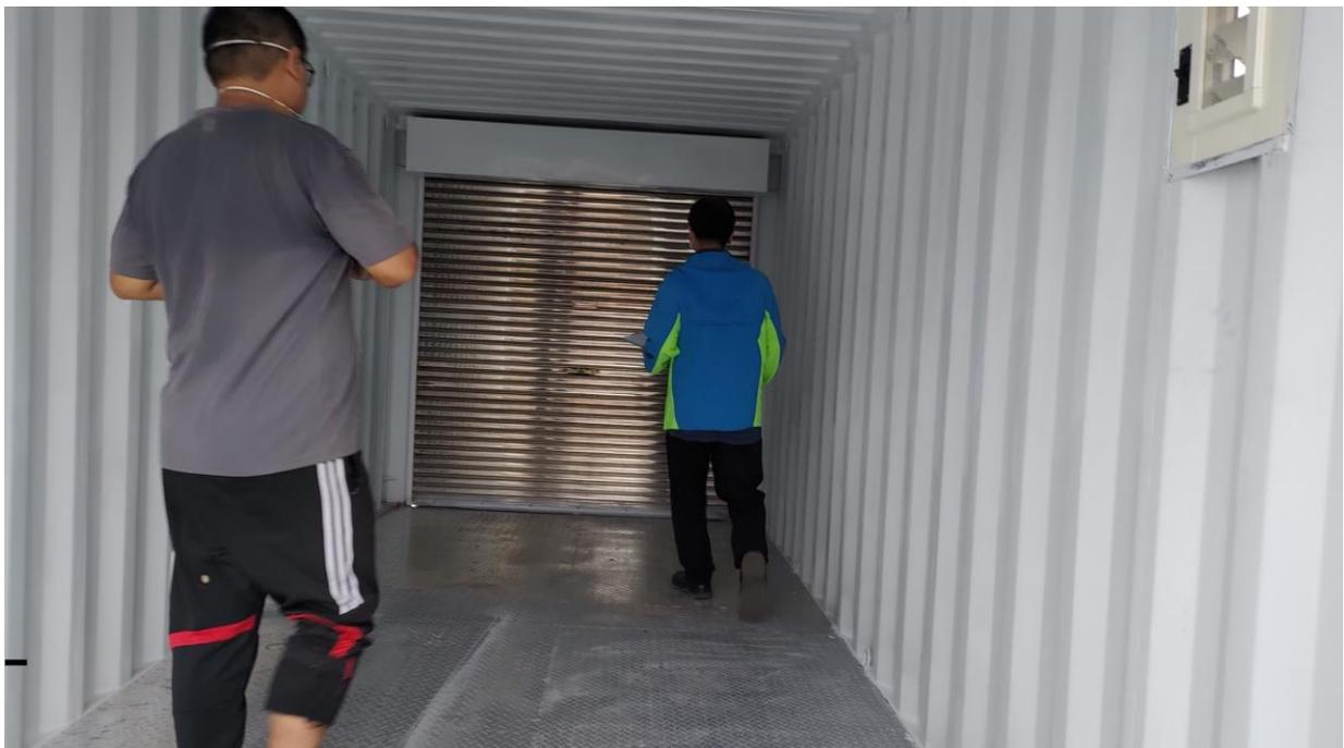
圖 3.8.2-3、貨櫃內部加設止滑防銹鋼板及加裝鍍鋅方管
