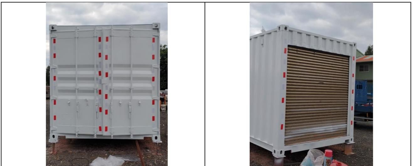
圖 3.8.2-6、貨櫃加設水泥板底座及加裝反光條
