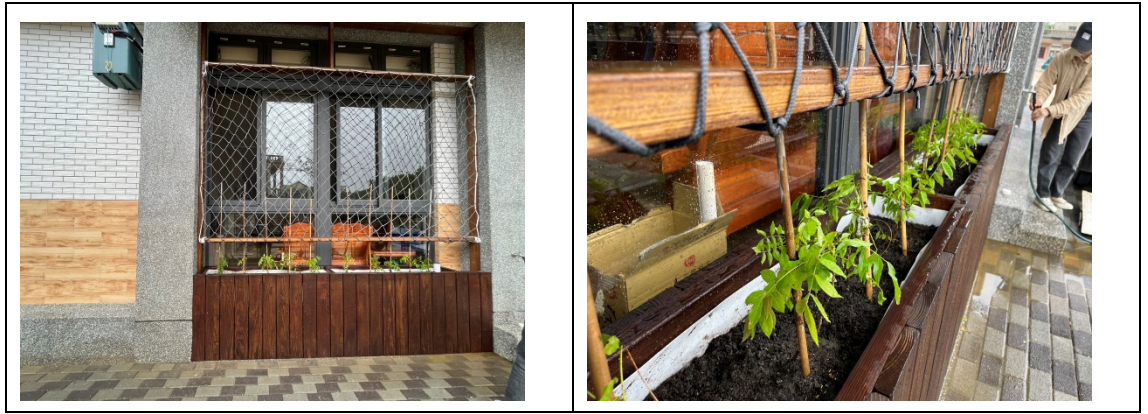
社區活動中心綠牆設置情形
