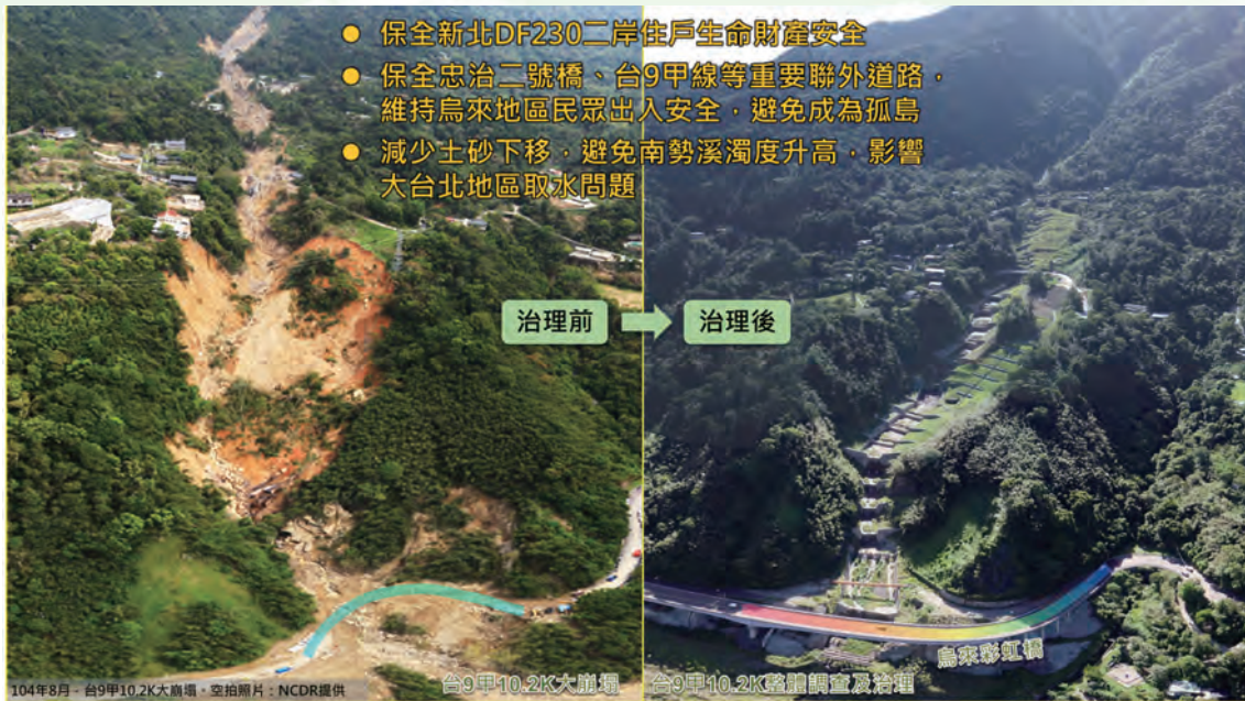
圖 4-17 大規模崩塌處理改善工程（以新北市烏來區 D002 為例）
