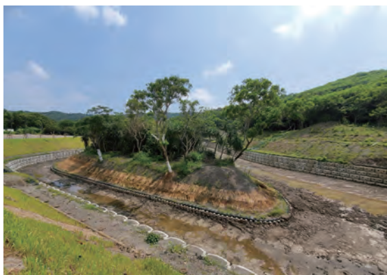
圖 4-60 屏東縣恆春鎮野溪整治工程
