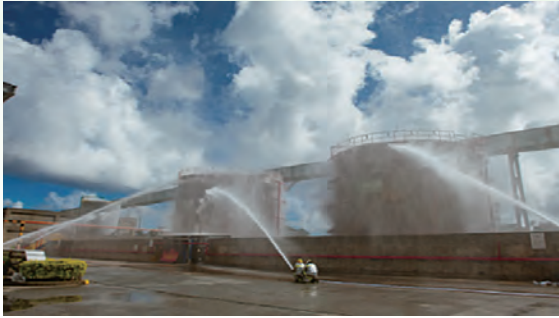
和平電力公司和平電廠設備故障與柴油槽設施防護演練
