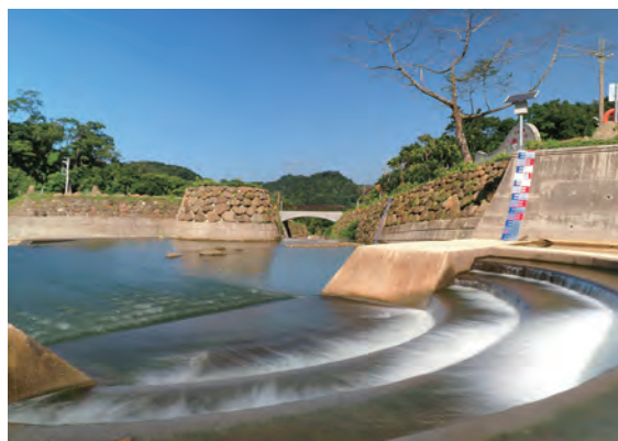
圖 4-61 臺中新社區抽藤坑溪整治工程
