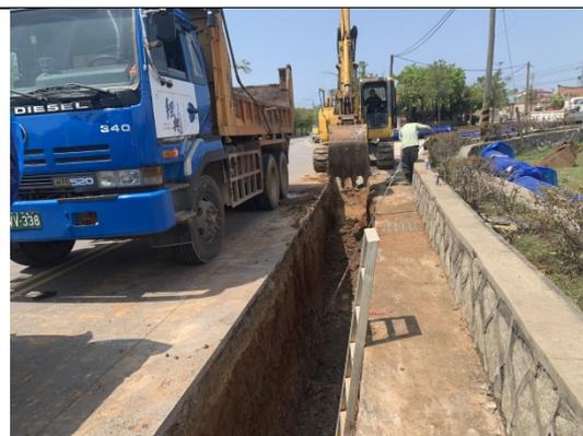
瓊安路送水管-管溝開挖
