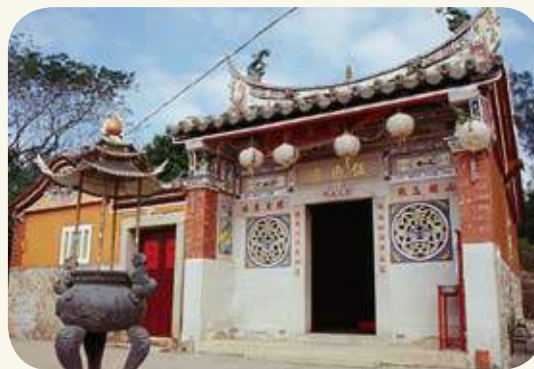
金湖鎮新頭村「伍德宮」改建前，塌岫左右對看牆龍虎堵石刻，以及鏡面身堵的「螭虎團爐」子午窗，細膩的雕工，頗具特色。
