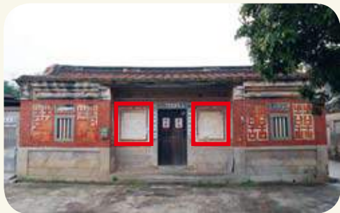
山前村18號宅鏡面明間身堵的「松鶴遐齡」（龍邊身堵），「逐祿高昇」（虎邊身堵）泥塑位置圖。
