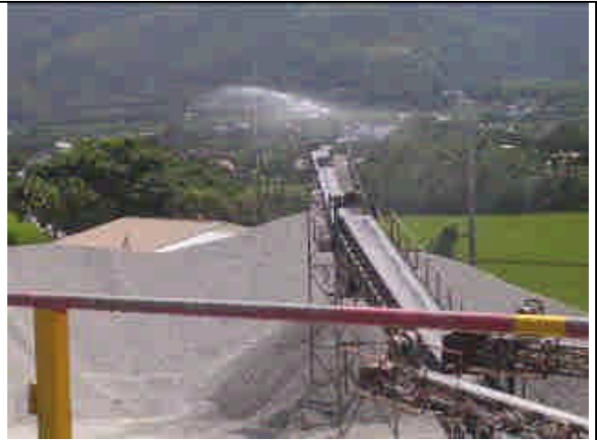
E.自動灑水設施(1)
