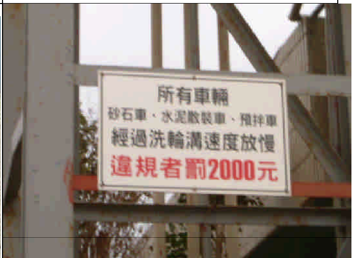
E.洗車告示牌
