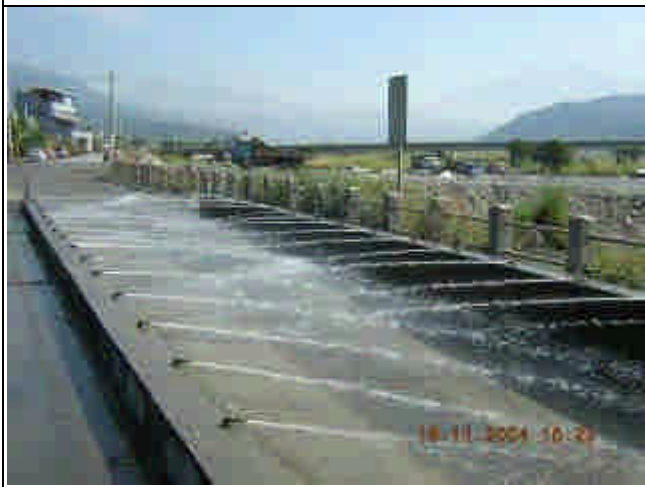
B.洗車平台-混凝土鋪設之洗車水槽
