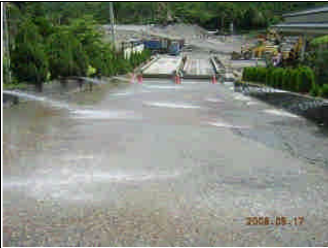
A.砂石車行駛路徑鋪設混凝土
