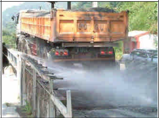
C.洗車台二側之噴水設備
