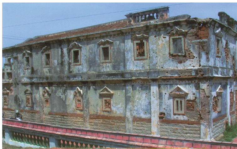
圖 2-5-3-7 金門古寧頭戰役北山村洋樓殘跡
