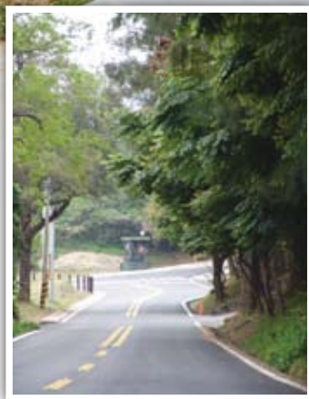
◀ 田墩聯外道路整建
