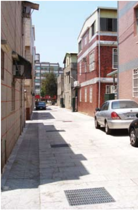
▲榮光新村鋪面(污水、電力、電信、自來水等管線地下化)改善工程
