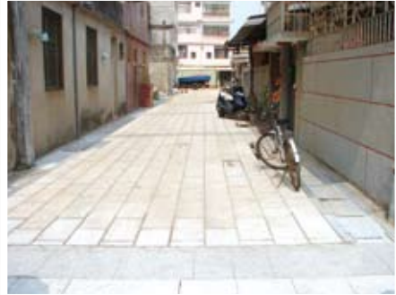
▲榮光新村鋪面(污水、電力、電信、自來水管線地下化)改善工程
