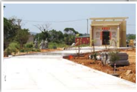
▲ 涵源宮積水改善工程
