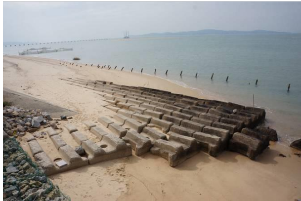
0113_232: 景觀步道下方消波塊處已有明顯之海岸堆積現象
