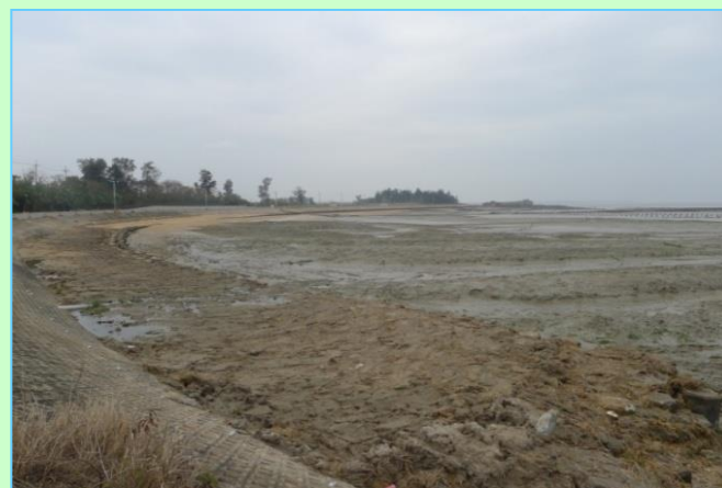
海堤及消波塊-淤積
