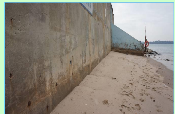
自來水廠海底管線口
