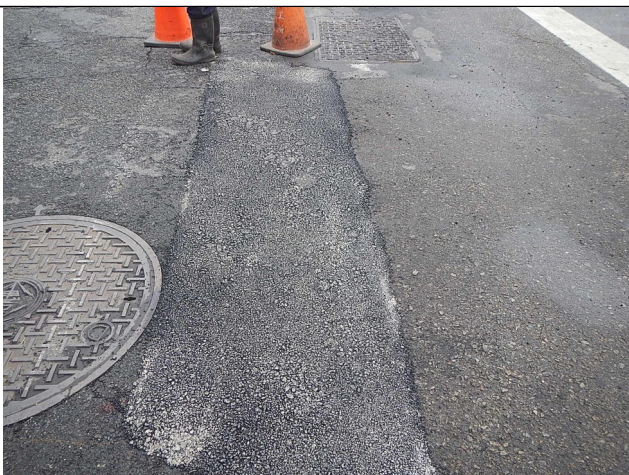
道路修補（環島北路二段）
