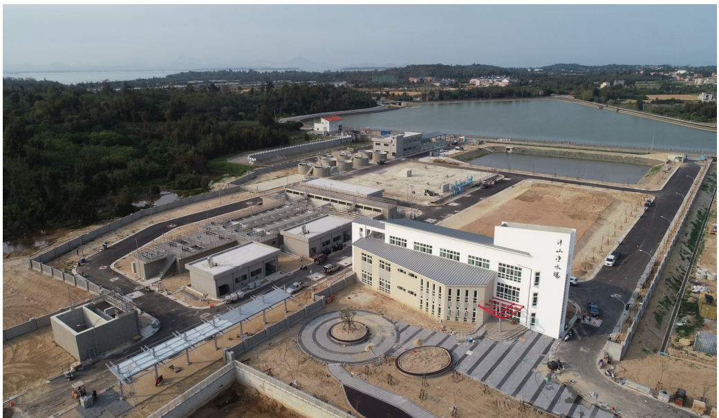
圖：「洋山淨水場新建工程」空拍照
