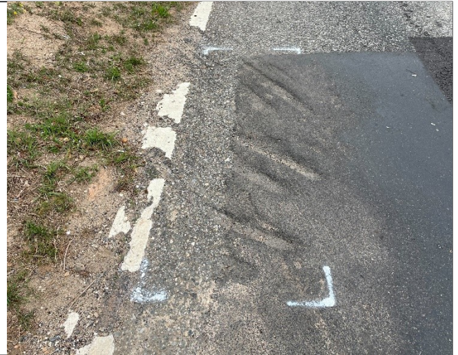
道路巡查（瓊安路）
