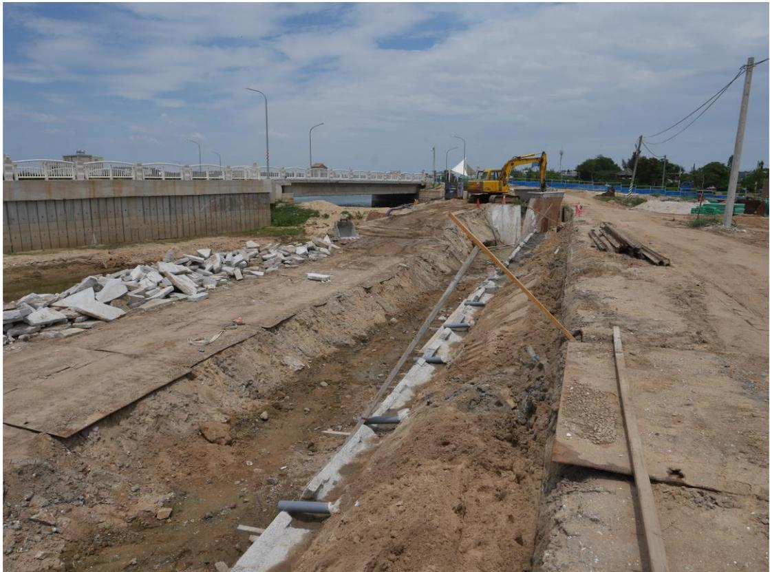
圖 3-6、2018 年 8 月，環島東路-金沙溪沿岸開始進行護岸灌漿作業
