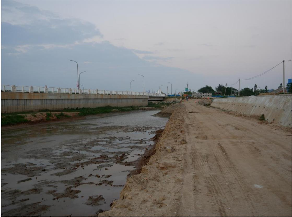
圖 3-7、2018 年 11 月，環島東路-金沙溪沿岸護岸灌漿作業已完成，但工程攔水堰仍未移除
