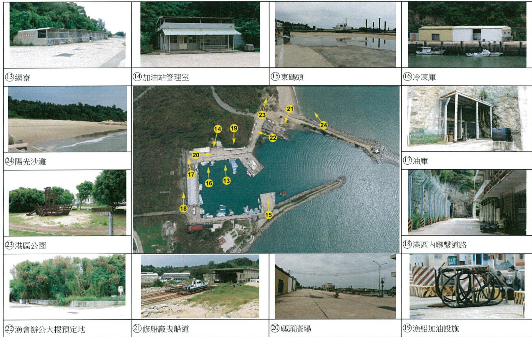
圖 6 新湖漁港港區內現況調查照片(二)
