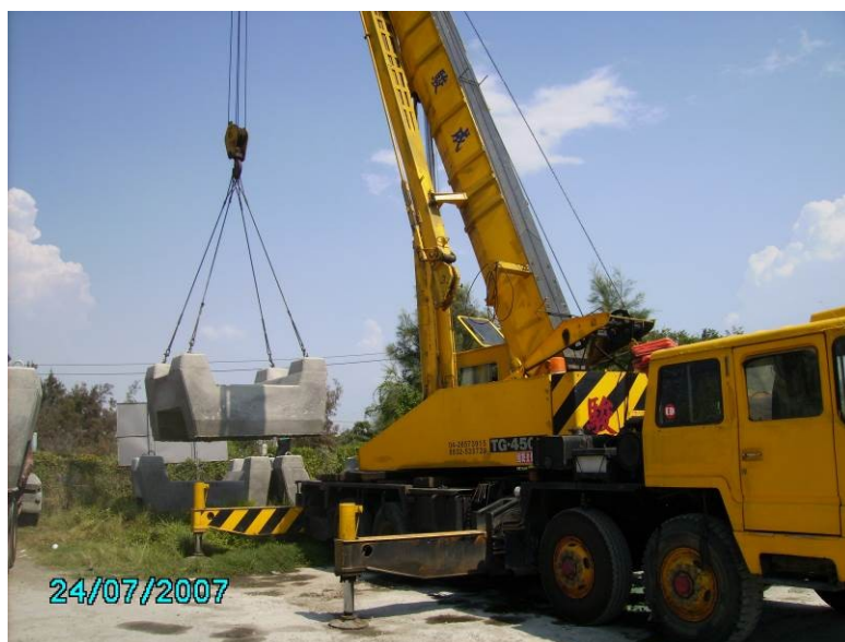
魚礁製作四個吊點投放時可以平衡穩定吊掛
