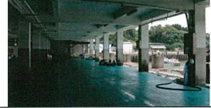
⑨漁會大樓一樓卸魚空間
