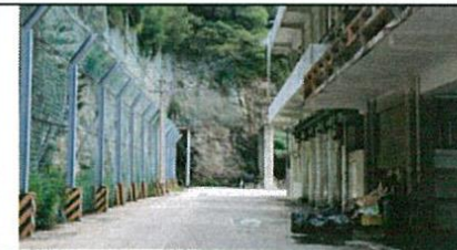
⑱港區內聯繫道路
