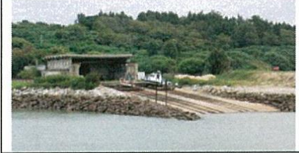
⑩修船廠曳船道
