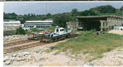
⑲修船廠曳船道
