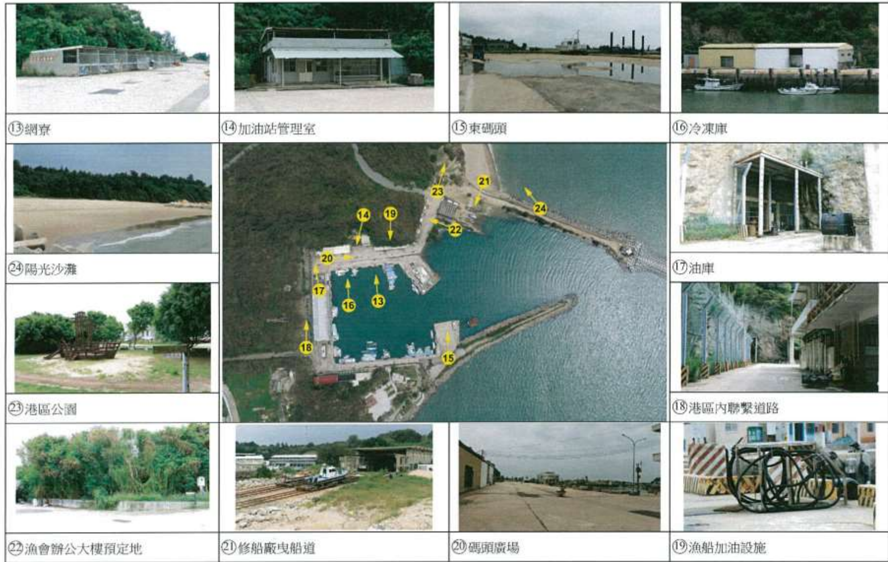
圖 6 新湖漁港港區內現況調查照片(二)
