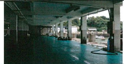
⑨漁會大樓一樓卸魚空間
