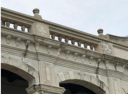
圖 2- 26：洋樓導水設計不良導致洩水污損牆體
