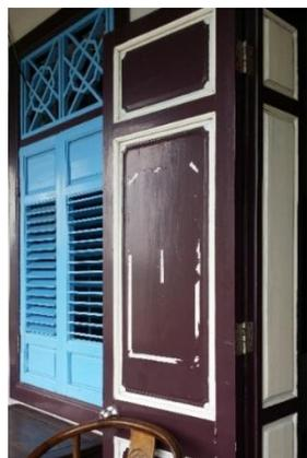
圖 2-10：洋樓木構門窗損壞情形
