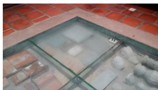
圖 2-9：洋樓天井地坪玻璃蓋板露化
