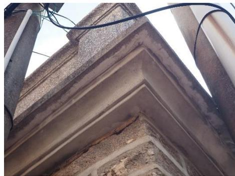
圖 2-47：建築新舊之間接合處已產生裂化
