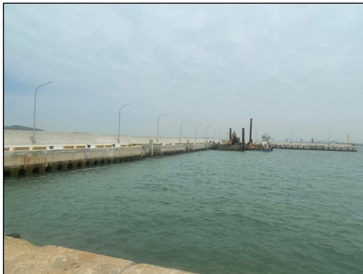
2. 辦理羅厝漁港改善工程：工作項目包含南內堤工程 49M、北碼頭及東碼頭工程 107M、浮動碼頭及引橋工程 46M、原有浮台修繕兩座、泊地浚挖工程，約增加船位 30 席，於 109 年 12 月 7 日完成總驗收通過，已完工結案，刻正接續辦理第二期工程規劃設計工程，經費 1.3 億元。
