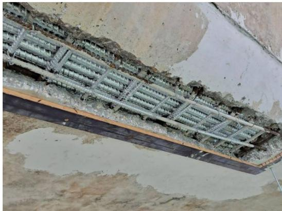
鋼筋表面塗布高鋅漆提昇防蝕效果
