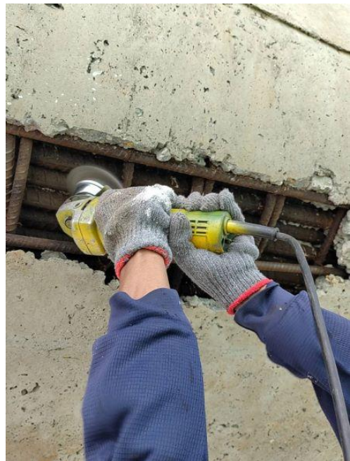
瑕疵處周邊混凝土敲除
