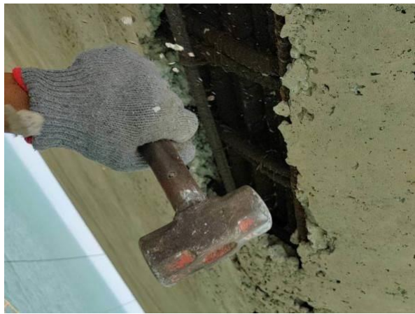
瑕疵處周邊混凝土敲除
