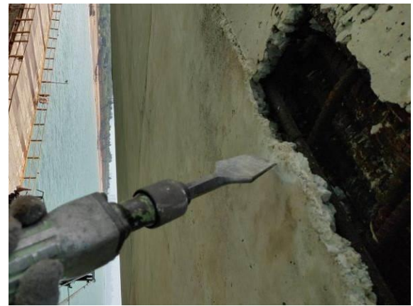
瑕疵處周邊混凝土敲除
