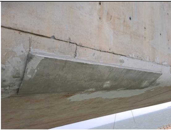
第1處改善後拆模情形
