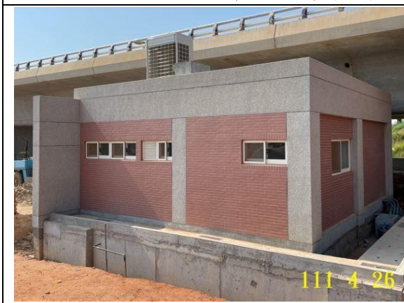
相片 9、交控機房完成
