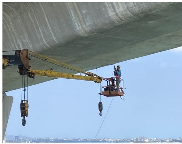
高空作業車搭載人員檢視缺失情形
