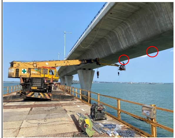
高空作業車搭載人員檢視缺失情形
