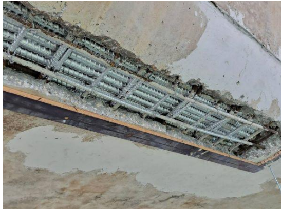
鋼筋表面塗布高鋅漆提昇防蝕效果
