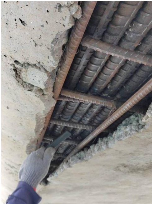
瑕疵處周邊混凝土敲除
