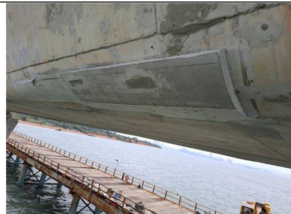
第2處改善後拆模情形
