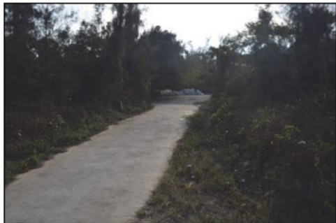
14. 后嶼坡聯繫道路
