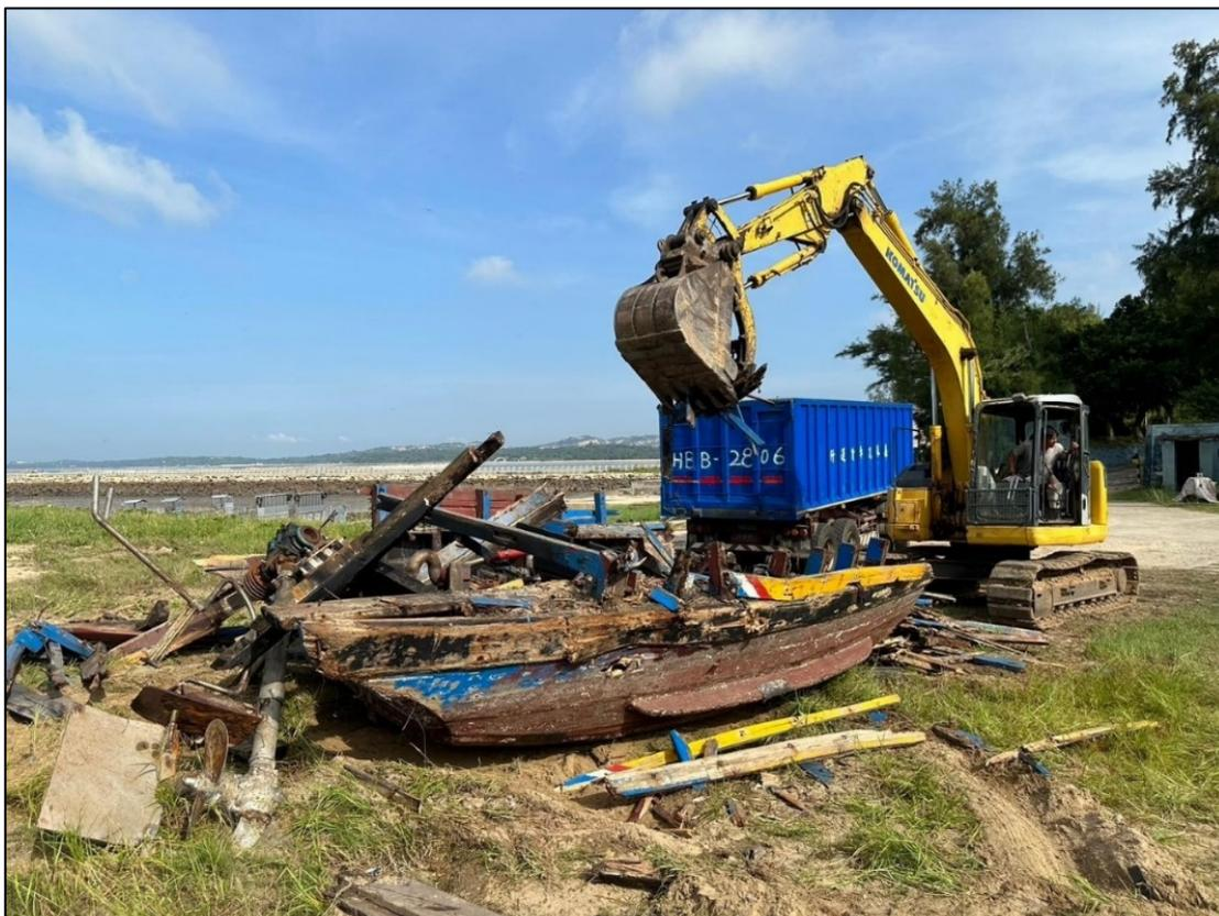
圖 44-將違法沒入漁船進行銷毀拆卸作業
