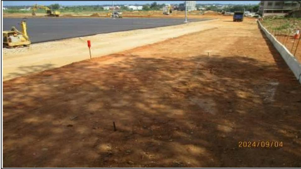
說明：新設臨時地坪高程基準點鋼筋端部未防護，為避免人員受傷，請改善。
