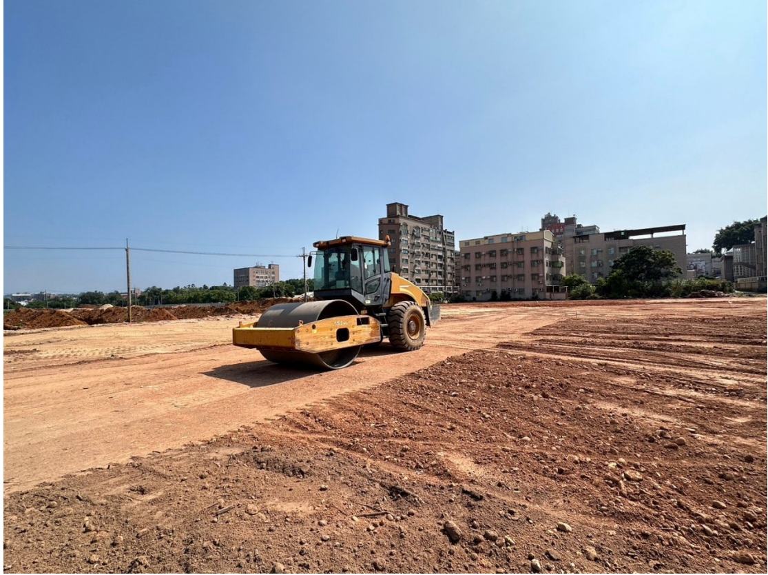
區域一整地夯實
