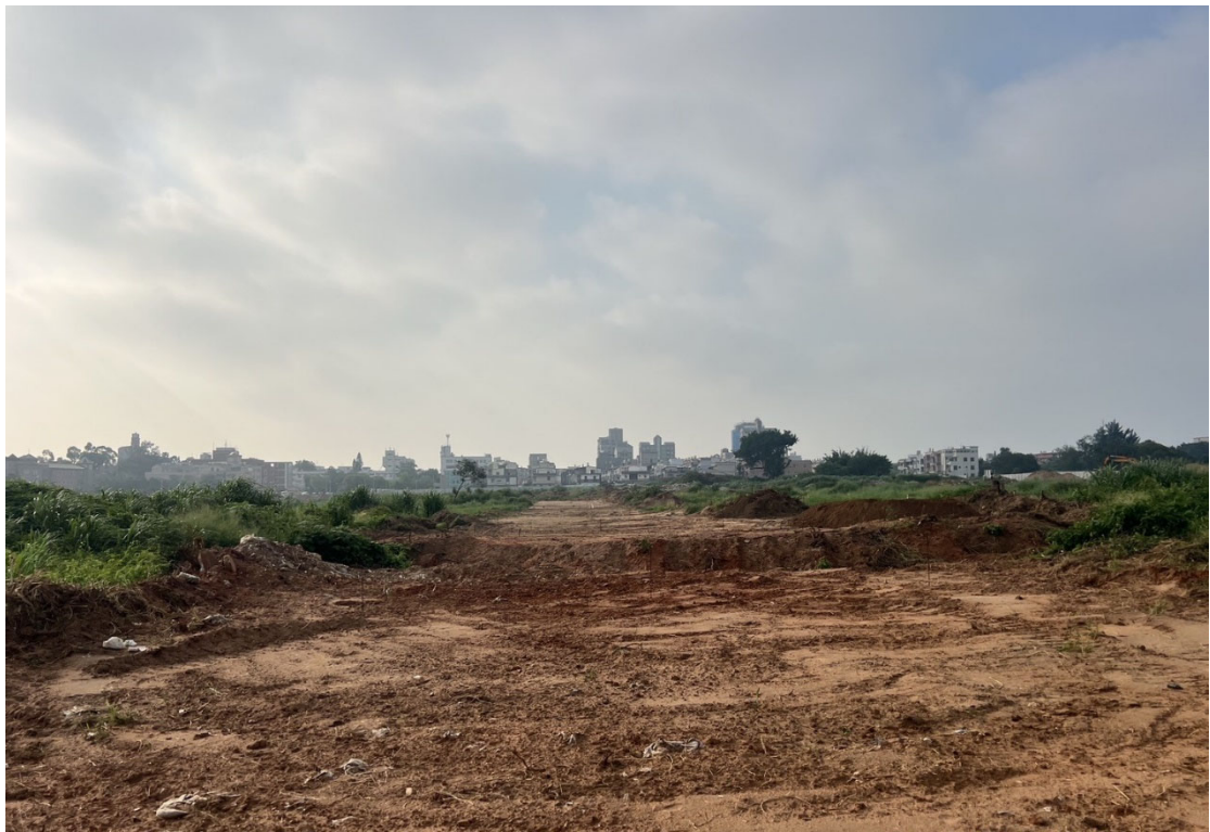
區域四道路開挖
