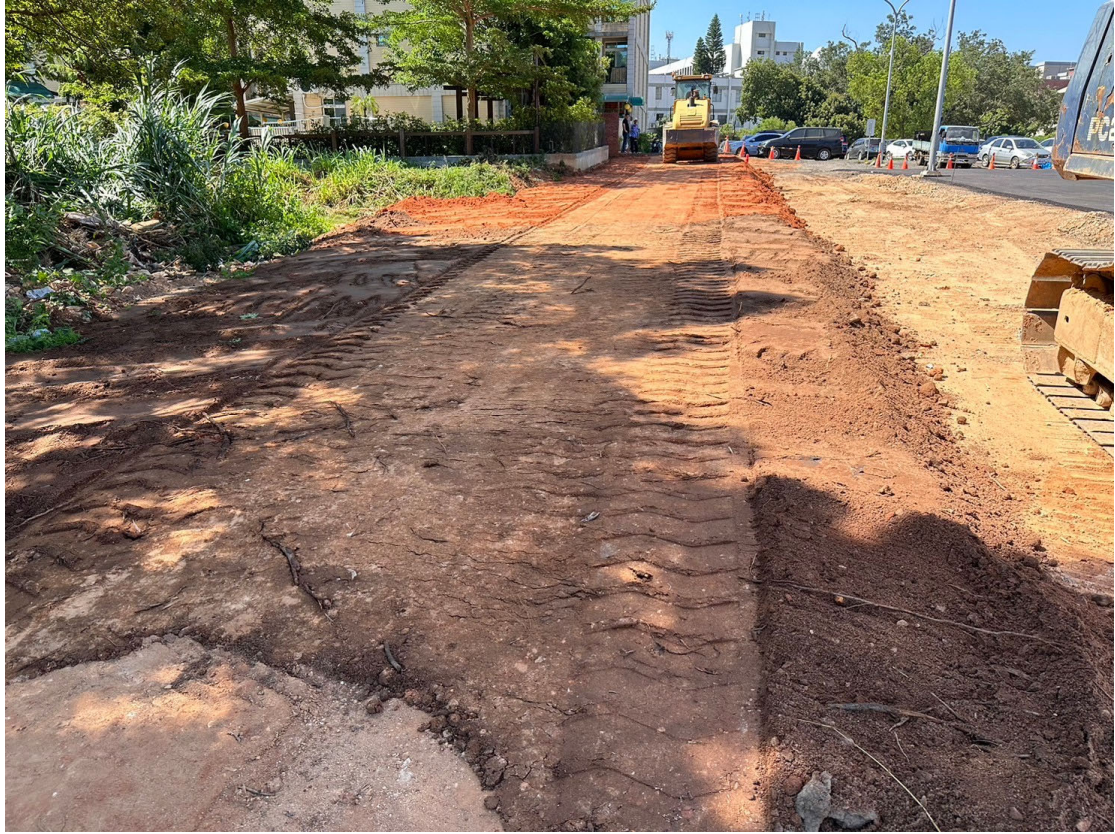
區域一社六停車場施工便道整地
