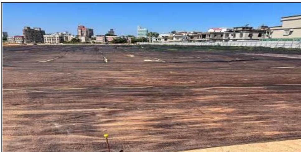
說明：工區土方裸露部分有設置防塵網及鋼筋保護套，請持續維持。
