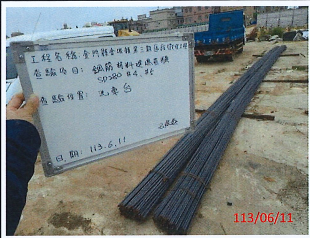
說明：D13(#4)、D16(#5)鋼筋材料進場一景
