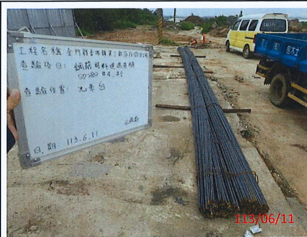
說明：D13(#4)、D16(#5)鋼筋材料進場一景
