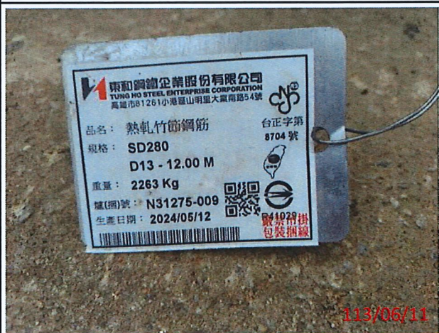
說明：D13(#4)鋼筋材料進場一景
