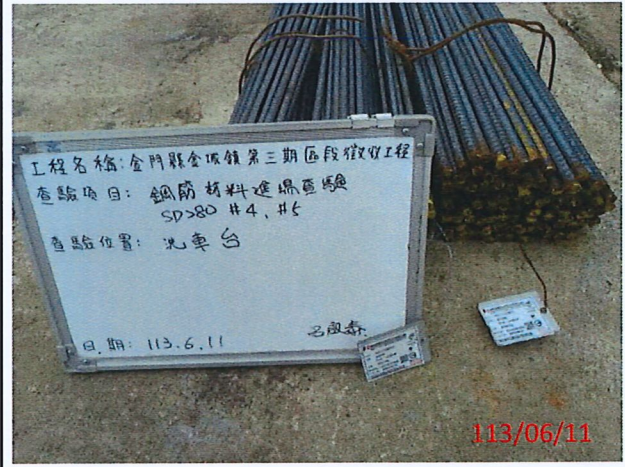
說明：D13(#4)、D16(#5)鋼筋材料進場一景
