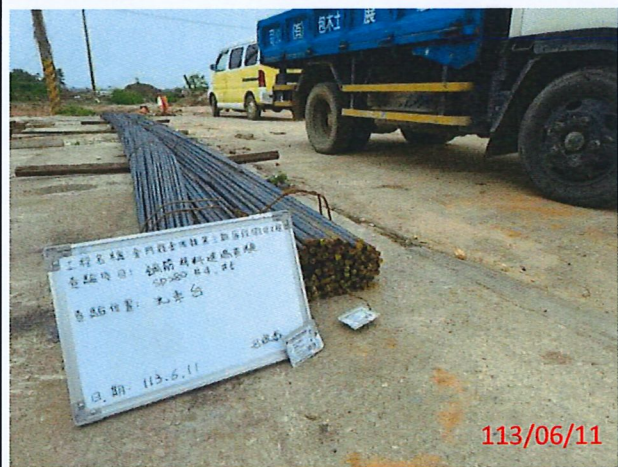
說明：D13(#4)、D16(#5)鋼筋材料進場一景
