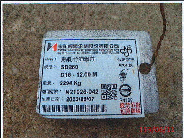
說明：D16(#5)鋼筋材料進場一景
