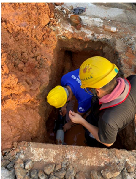
自來水管線搶修作業
