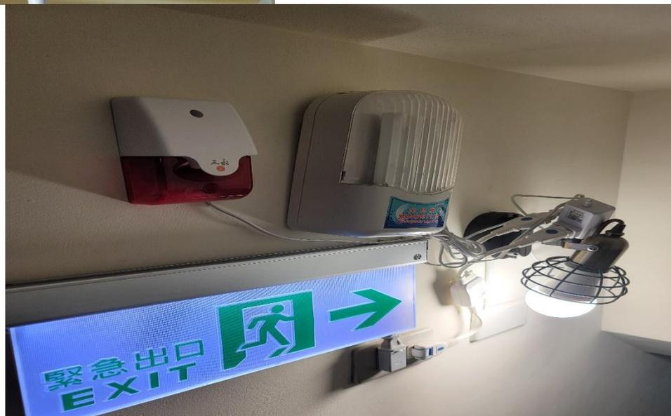
同一個插座加裝多向插頭，延長線同一時間使用多種耗電及發熱電器產品。
