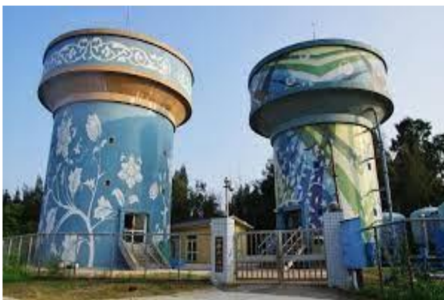
昔果山配水塔
