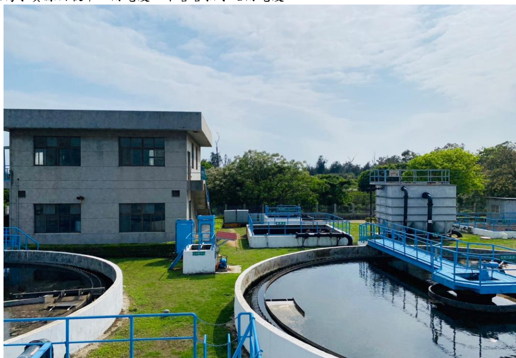
發電機房及終沉池
