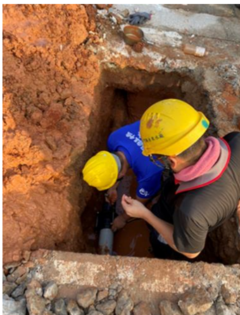
自來水管線搶修作業
