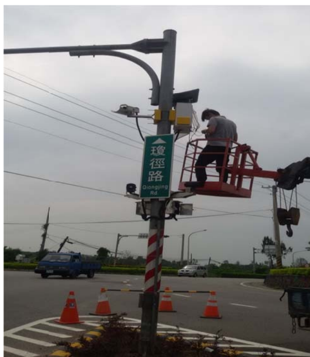
圖 6.3 固定式車辨系統安裝施工圖
