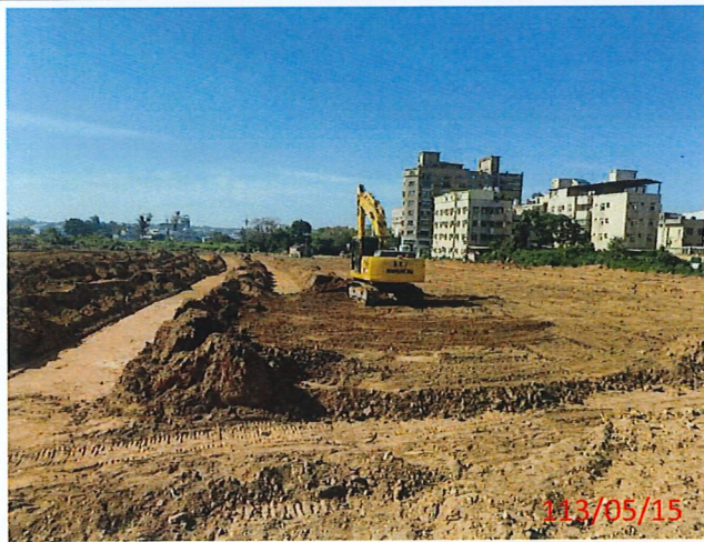
說明：第二層30~60cm土方回填夯實
