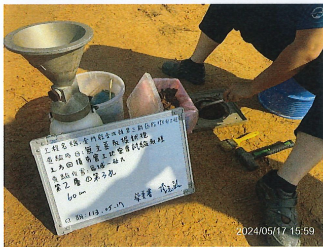
說明：工地密度試驗取樣第3孔
