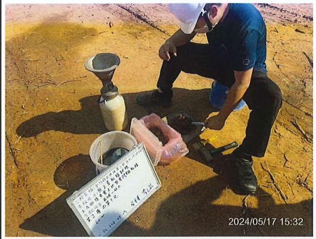
說明：工地密度試驗取樣第1孔
