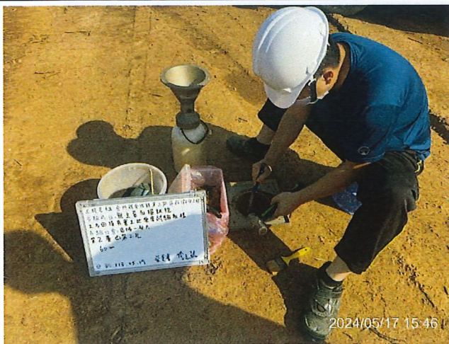
說明：工地密度試驗取樣第2孔
