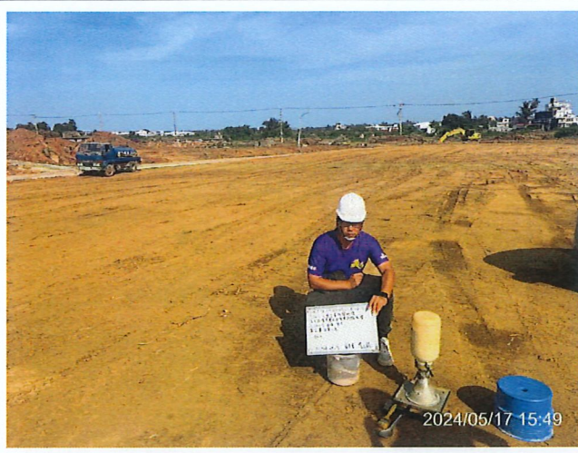
說明：工地密度試驗取樣第2孔
