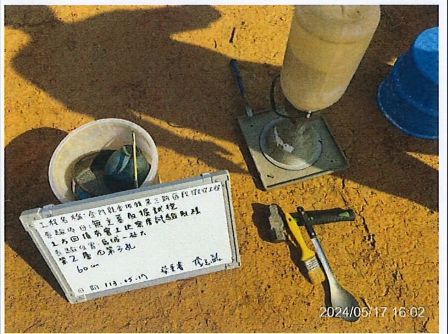
說明：工地密度試驗取樣第3孔
