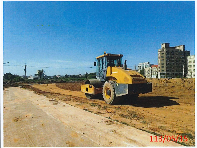
說明：第二層30~60cm土方回填夯實
