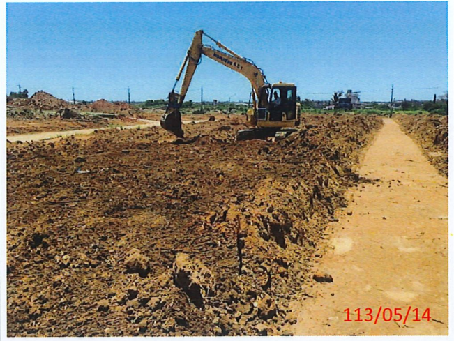
說明：第二層30~60cm土方回填夯實
