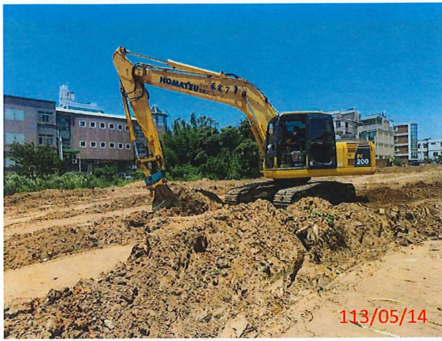
說明：第二層30~60cm土方回填夯實
