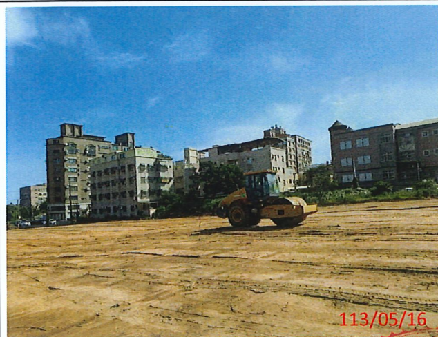
說明：第二層30~60cm土方回填夯實
