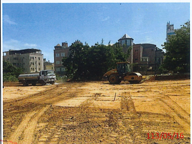
說明：第二層30~60cm土方回填夯實
