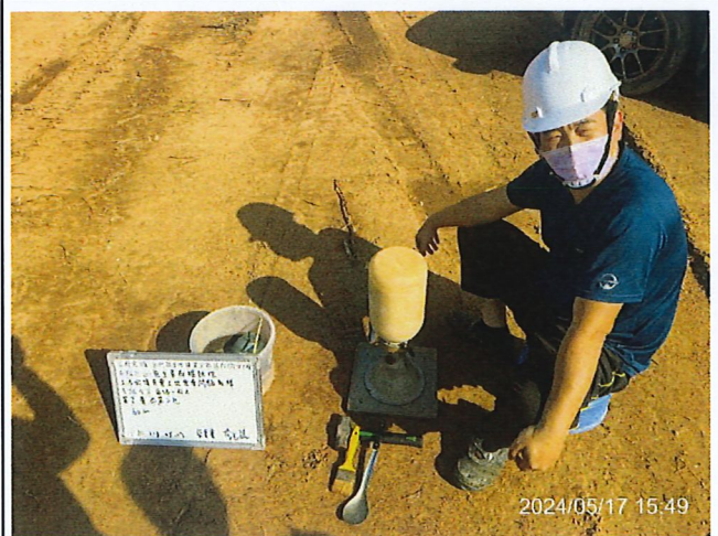
說明：工地密度試驗取樣第2孔
