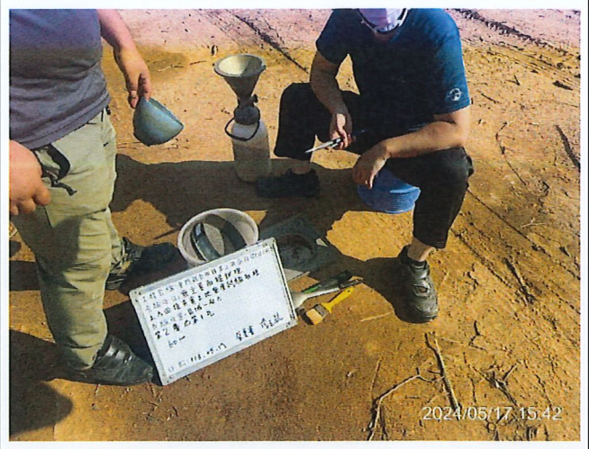
說明：工地密度試驗取樣第2孔
