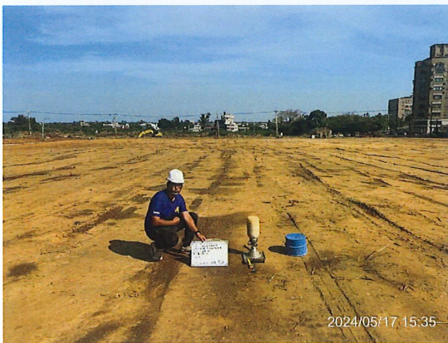
說明：工地密度試驗取樣第1孔
