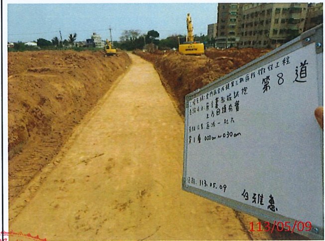
說明：第8道第一層0~30cm土方回填夯實
