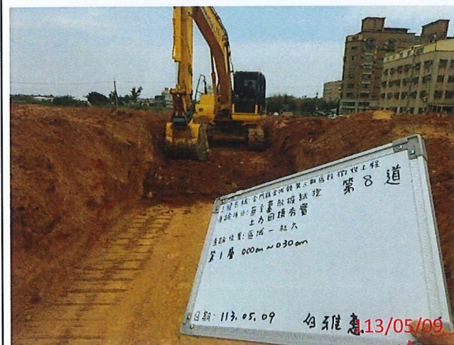
說明：第8道第一層0~30cm土方回填夯實
