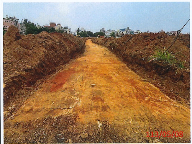
說明：第1~4道第一層0~30cm土方回填夯實
