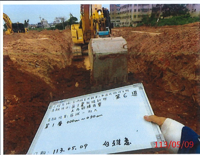
說明：第6道第一層0~30cm土方回填夯實
