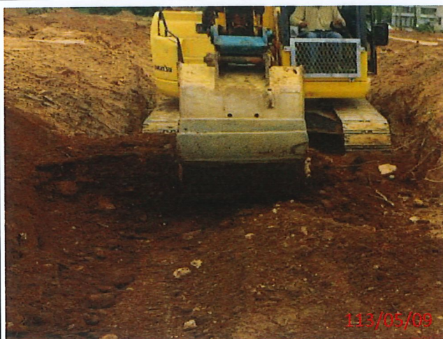
說明：第5道第一層0~30cm土方回填夯實
