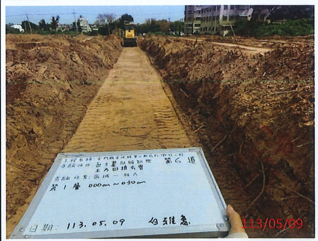
說明：第6道第一層0~30cm土方回填夯實
