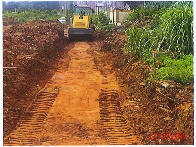
說明：第1~4道第一層0~30cm土方回填夯實
