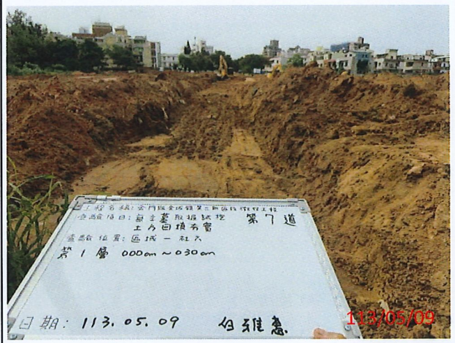
說明：第7道第一層0~30cm土方回填夯實
