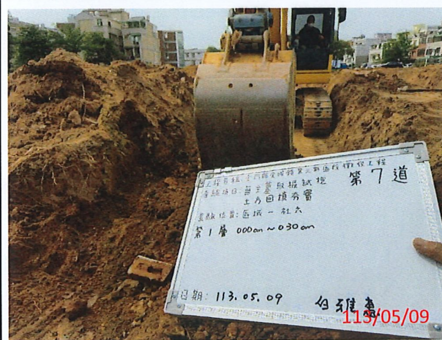
說明：第7道第一層0~30cm土方回填夯實
