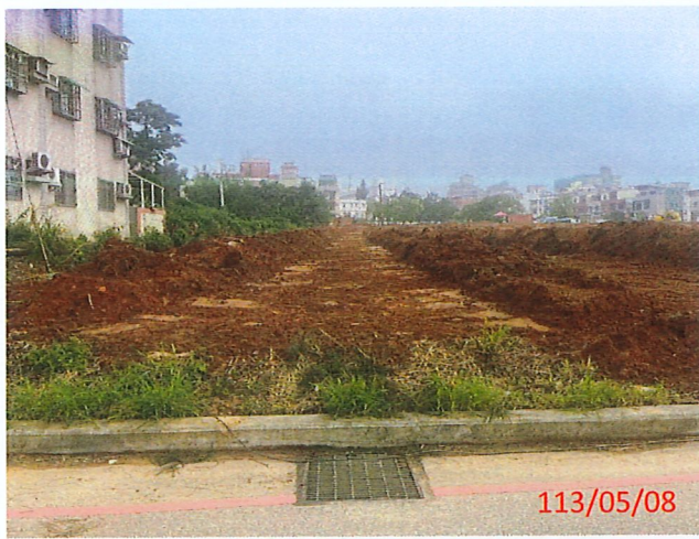
說明：第1~4道第一層0~30cm土方回填夯實
