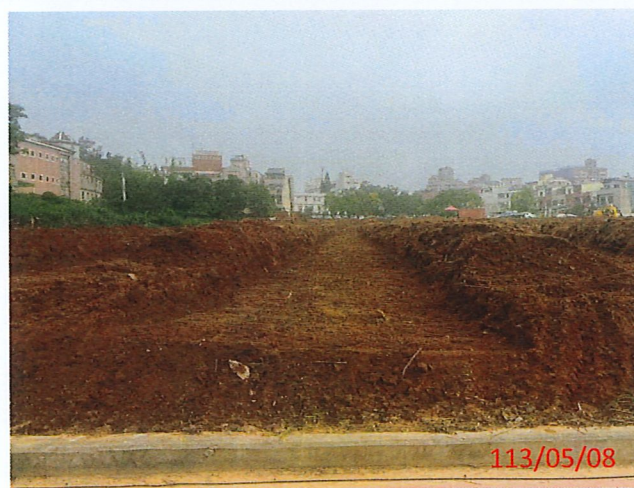
說明：第1~4道第一層0~30cm土方回填夯實
