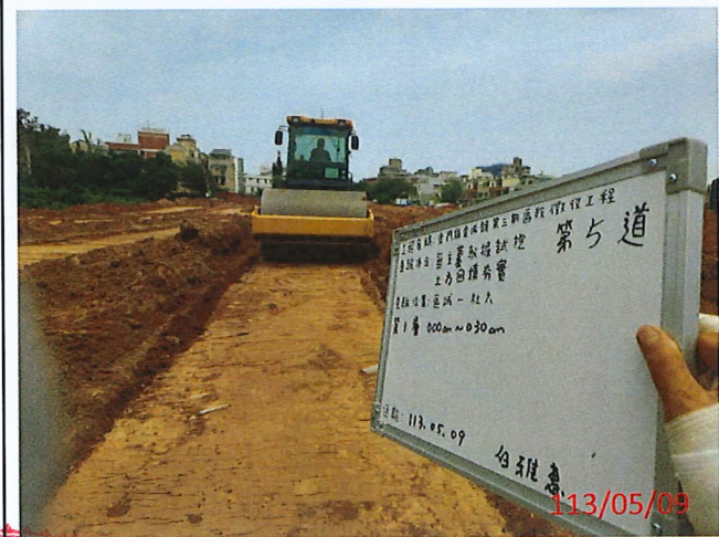
說明：第5道第一層0~30cm土方回填夯實
