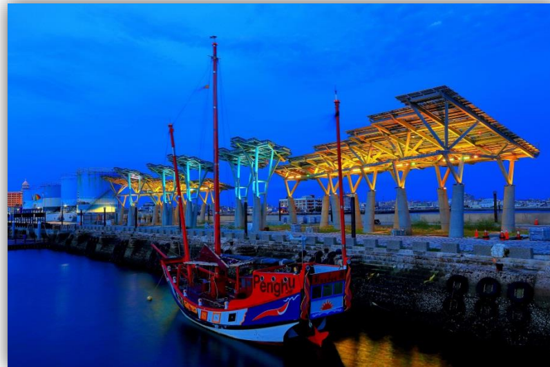
澎湖第一漁港-戶外休憩光廊
