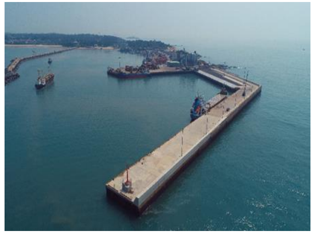
南防波堤延建 90 公尺，提升港池靜穩度。
