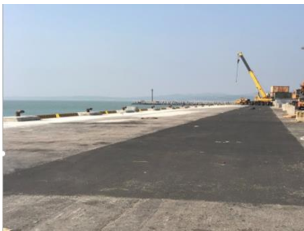
既有 S6 碼頭整修，提升碼頭裝卸作業效率。
