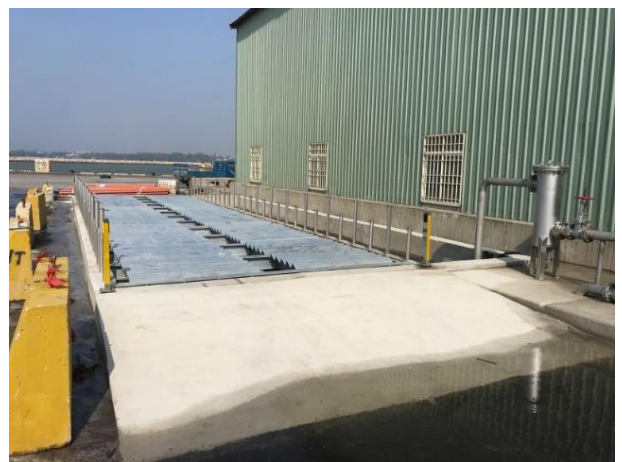
增設洗車池乙座，減少碼頭粉塵飛揚。
