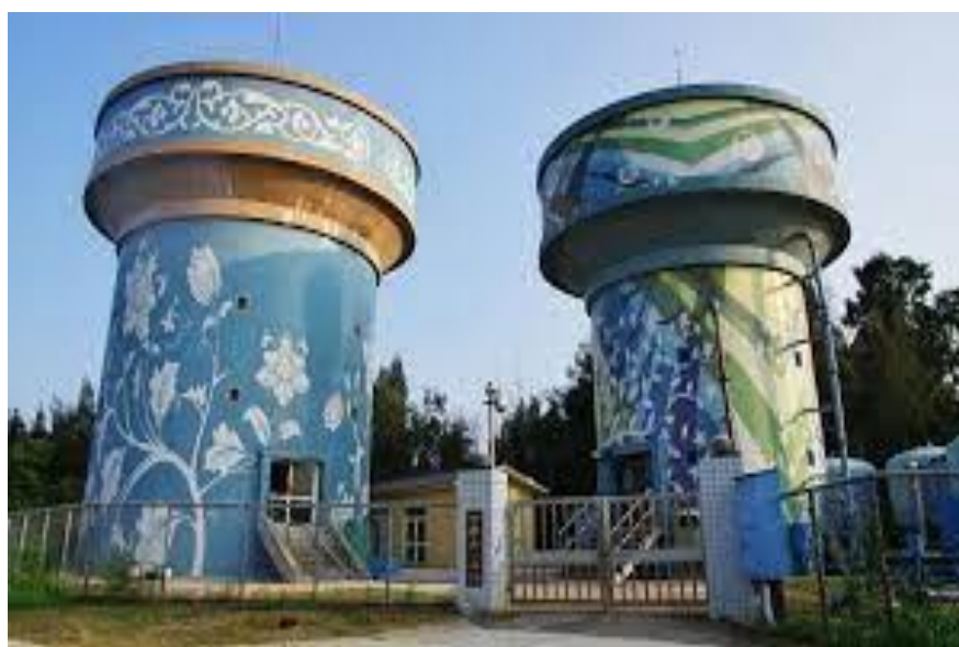
昔果山配水塔
