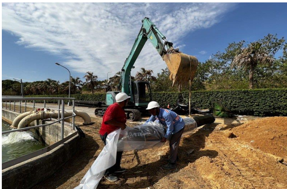
金東地區湖庫導水管改善工程施工情形
