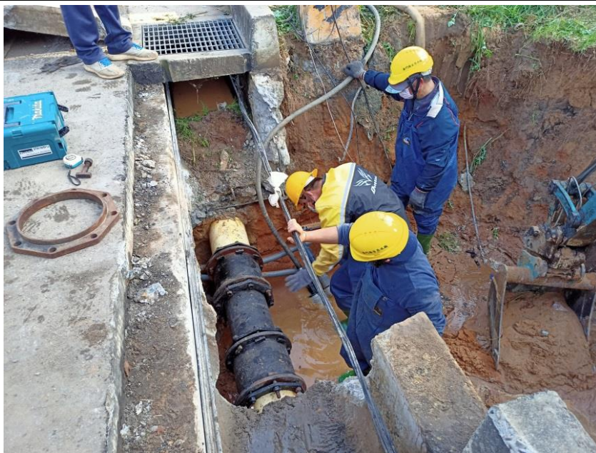
自來水管線搶修作業
