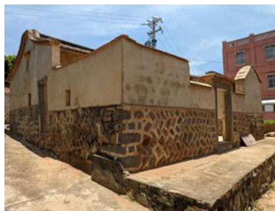
112 年度烈嶼鄉頹屋危屋處理作業工程
