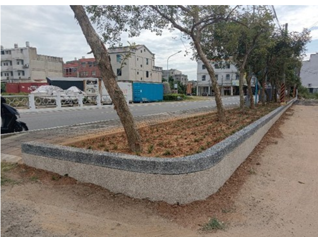
烈嶼鄉九井路路側環境整建工程
