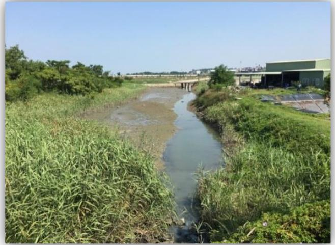
主渠道護岸崩壞渠底淤積
