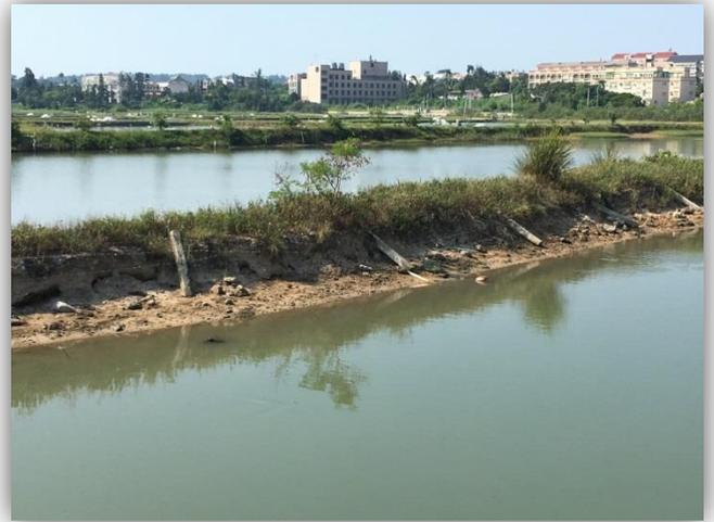
主渠道護岸崩壞基礎流失
