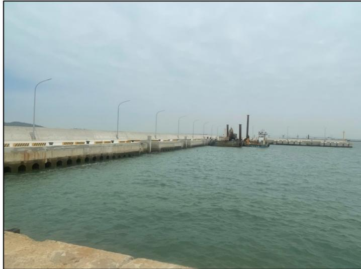
2. 辦理羅厝漁港改善工程：工作項目包含南內堤工程 49M、北碼頭及東碼頭工程 107M、浮動碼頭及引橋工程 46M、原有浮台修繕兩座、泊地浚挖工程，預期增加船位 30 席，於 109 年 12 月 7 日完成總驗收通過，已完工結案，刻正接續辦理第二期工程規劃設計工程，經費 1.3 億元。
