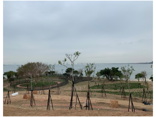
海濱公園堆坡工程
