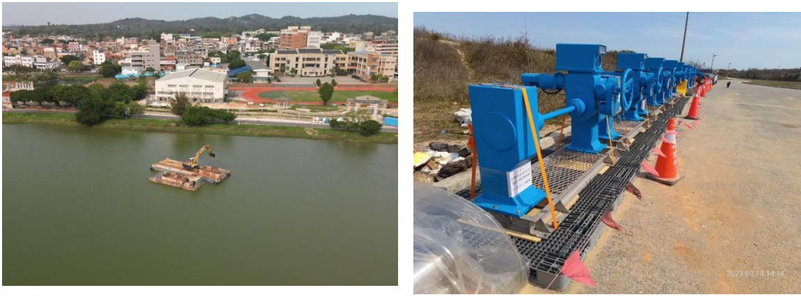
圖 1-「榮湖水庫及田浦水庫浚淤等周邊設施改善工程」及「金湖水庫周邊設施改善工程」施工照
