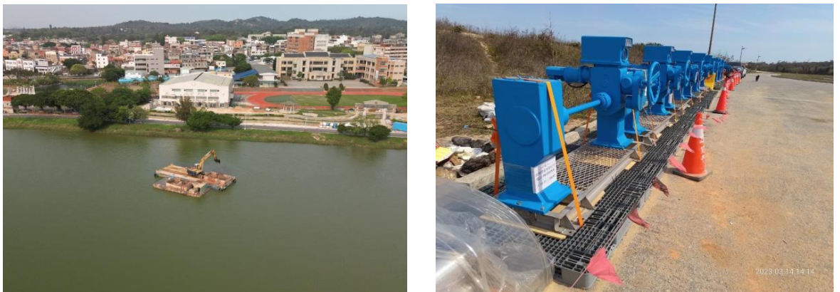
圖 1-「榮湖水庫及田浦水庫浚渫等周邊設施改善工程」及「金湖水庫周邊設施改善工程」施工照
