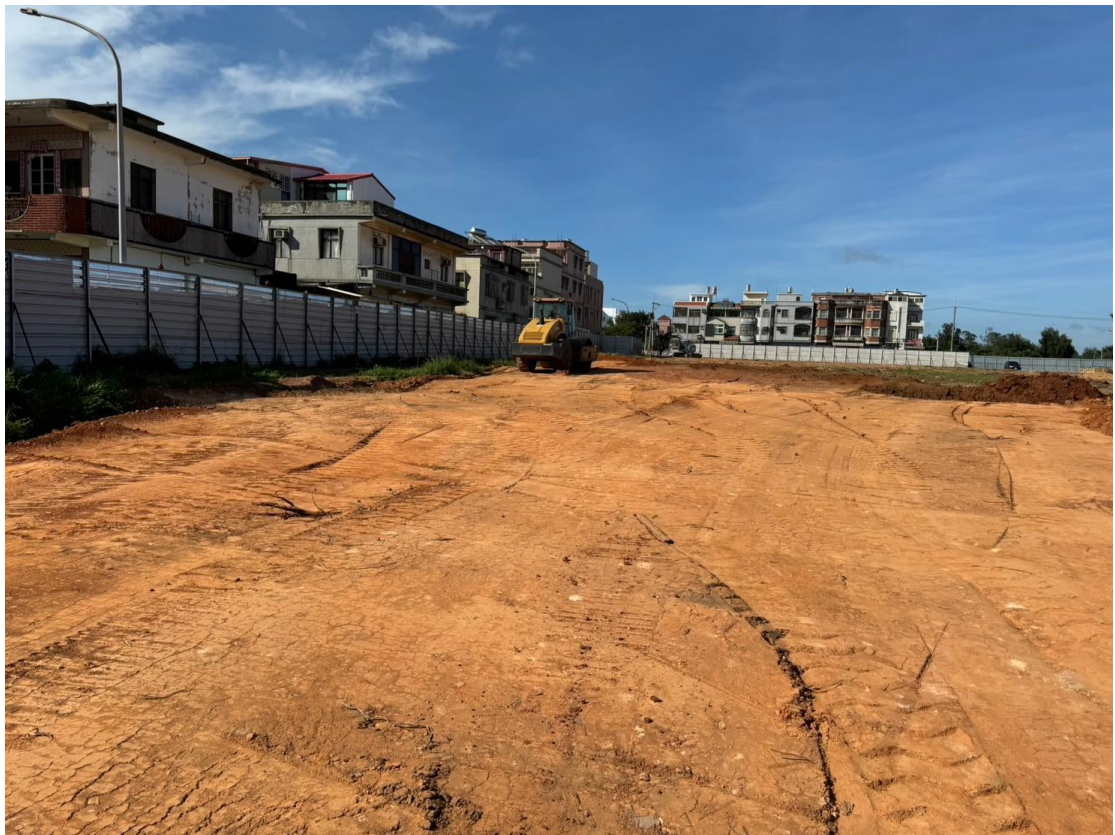
區域二底土夯實整平
