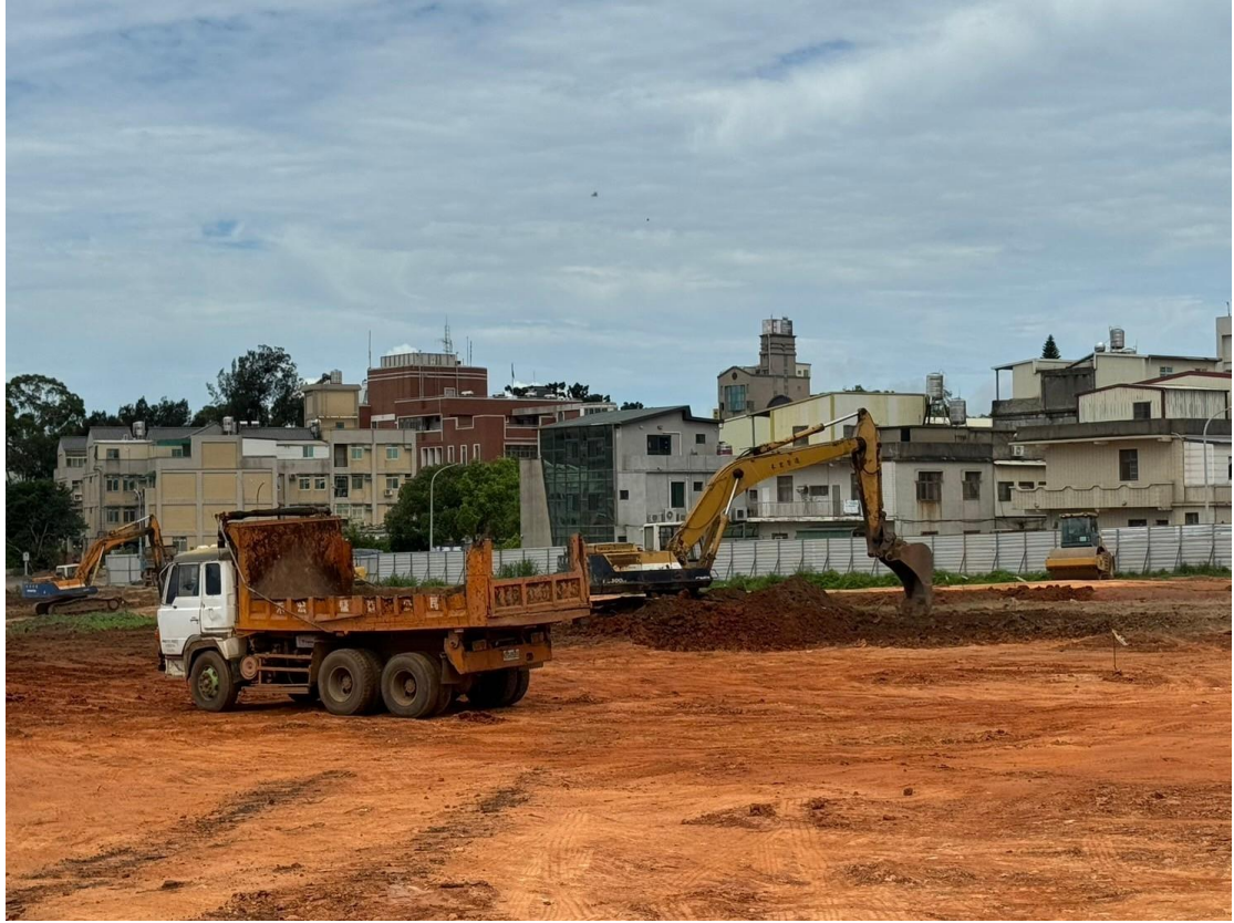
區域二基地及路幅開挖
