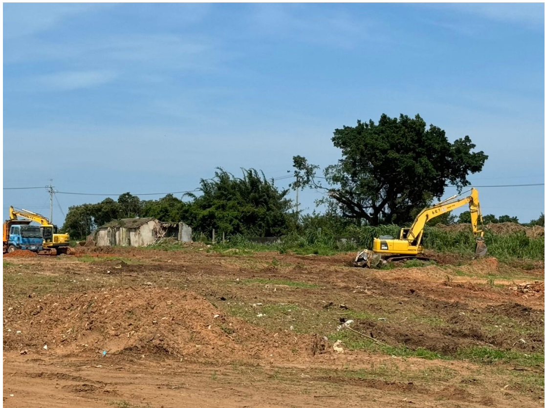
區域三及區域四清除及掘除
