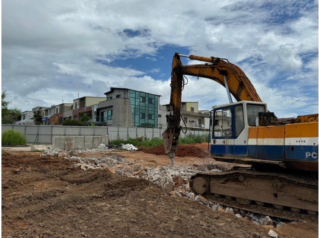
區域二既有建築物及結構物拆除
