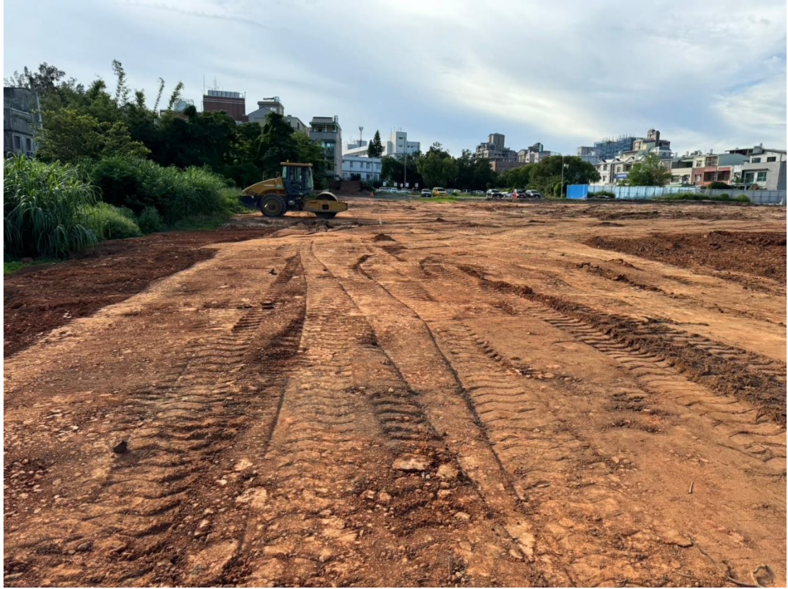
區域一底土夯實整平
