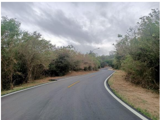
烈嶼鄉 110 年度上庫至青岐等道路改善暨電力管路地下化工程
