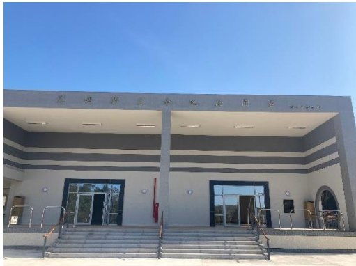
烈嶼鄉殯葬設施服務空間新建工程
