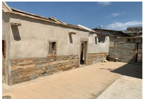
111 年度烈嶼鄉頽屋危屋處理作業工程
