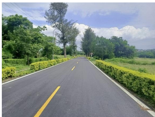
烈嶼鄉上林至西方暨湖下至東崗機場道路改善計畫工程
