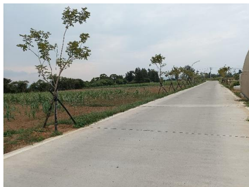
烈嶼鄉貓公石聯外道路改善工程
