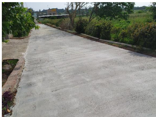
110 年度烈嶼鄉道路修補工程
