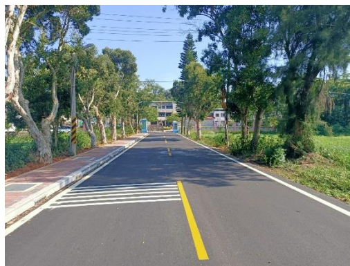
烈嶼鄉卓環國小通學動線提升道路品質計畫工程
