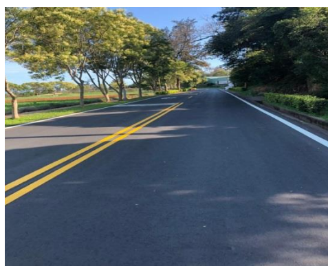
烈嶼鄉八青路經陽山公園至東崗道路改善工程
