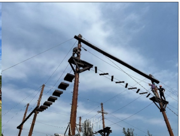
金門縣柳營園區體驗設施建置統包工程
