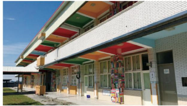
圖2.3 為校舍補強實際情況；部分柱採用擴柱補強，表面貼上磁磚美化，提升補強後附加價值（許庭璋 攝）
