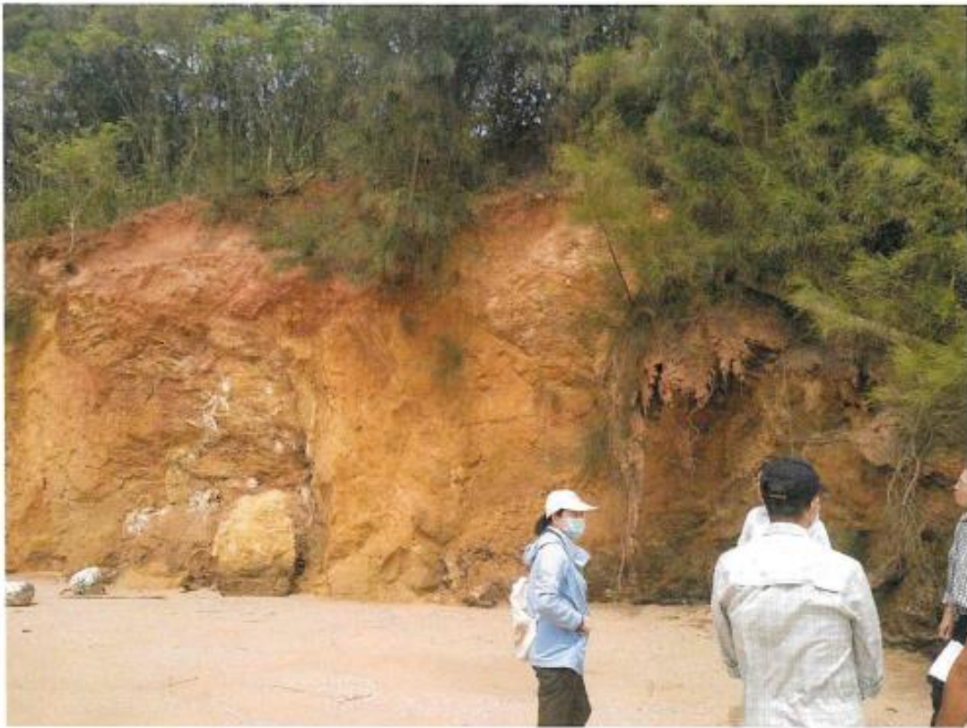
圖 3、有紅土崩落風險處
